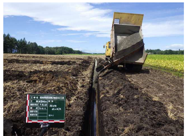
工事中 管敷設後の疎水材投入状況
