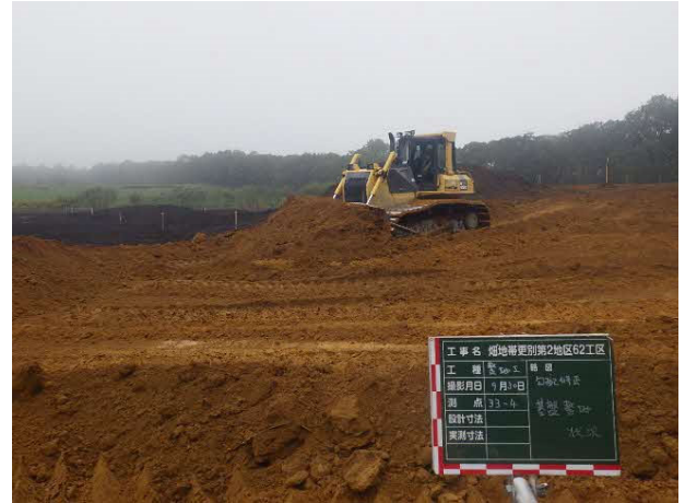
工事中 基盤整地状況
