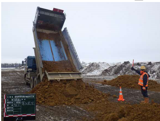
工事中 客土材搬入状況
