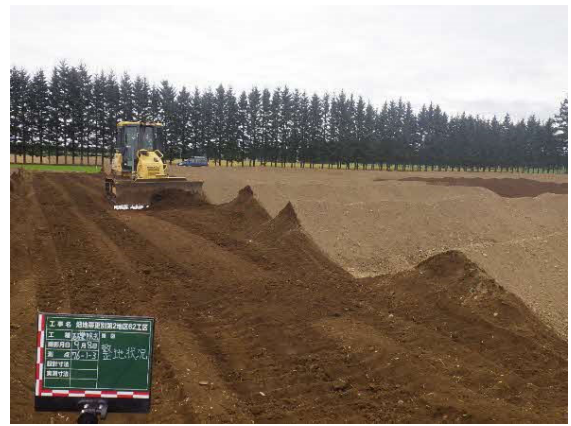
工事中 除礫後整地状況
