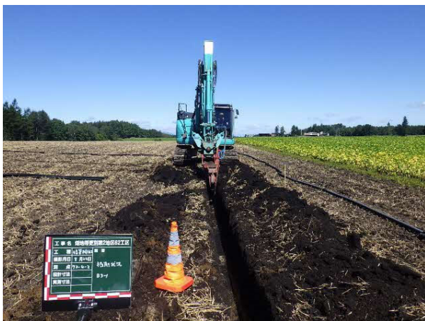
工事中 掘削状況
