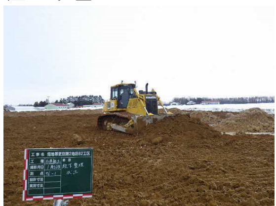
工事中 客土材放下整理状況
