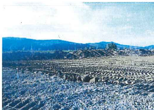
写真② 区画整理施工状況
