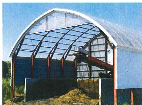
写真③ 堆肥積込場
