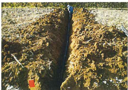
写真③ 暗渠排水施工状況
