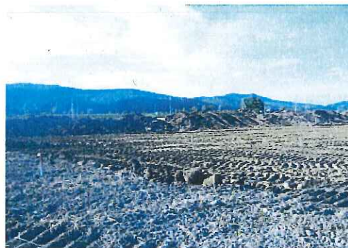
写真② 区画整理施工状況
