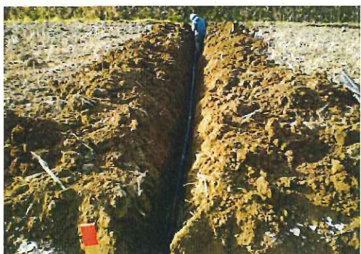
写真③ 暗渠排水施工状況
