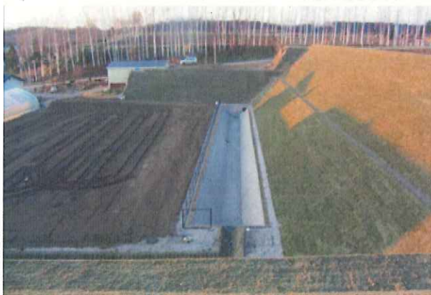
写真⑨ 沈砂池
