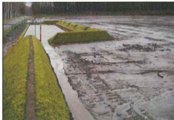
写真⑩ 大雨時降雨が沈砂池へ流れる
