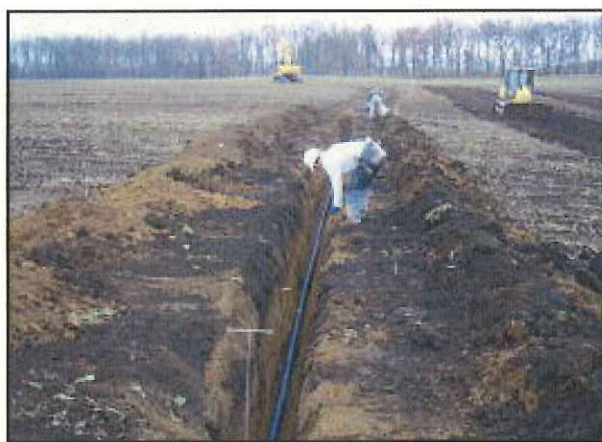
写真② 暗渠排水施工状況
