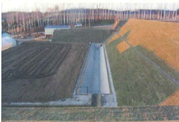
写真⑨ 沈砂池
