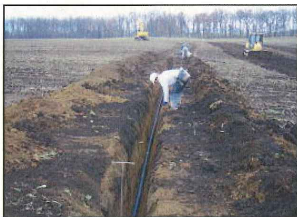
写真② 暗渠排水施工状況
