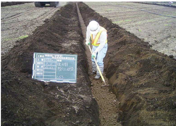
暗きょ排水施工状況
