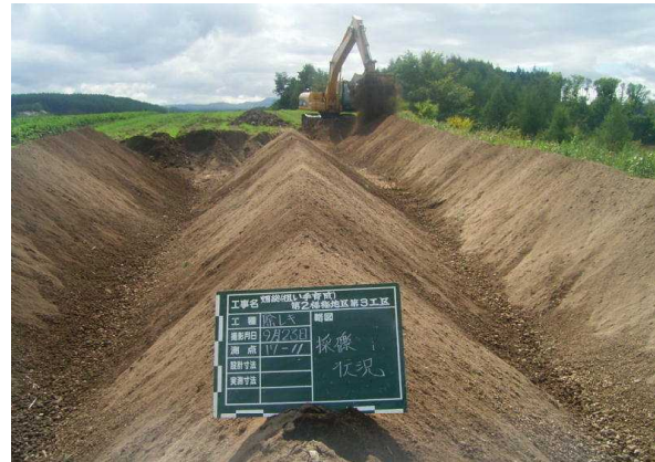
土層改良（除礫）施工状況
