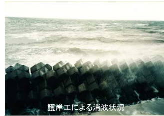
護岸工による消波状況
