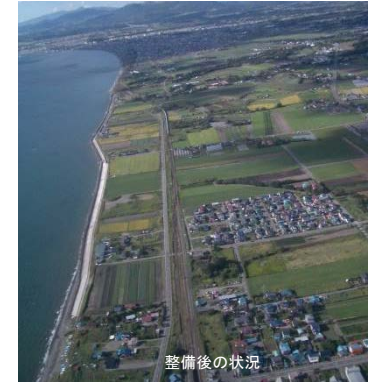
整備後の状況
