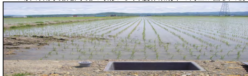
ほ場の大区画化と地下かんがいシステムの設置
