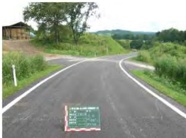
事業実施前は、農道が未舗装であり幅員も狭く縦断勾配も急であったため速度を落として走行していたが、農道整備によりアスファルト舗装となり農産物輸送が効率的となった。
