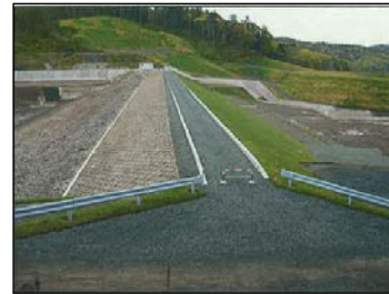
実施後 （撮影平成21年）
