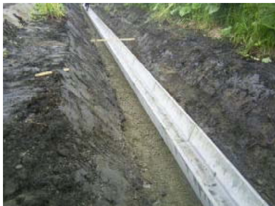
〈排水路〉（平成20年撮影）
