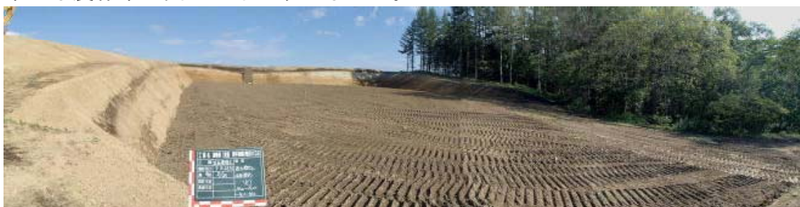
区画整理施工ほ場状況
