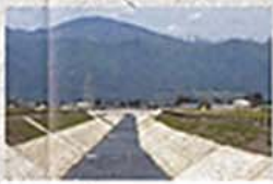
あづみ野排水路
