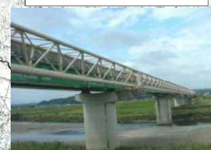
本庄川水管橋
