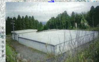
角上揚水機場・FP
