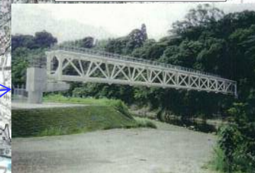
清武川水管橋
