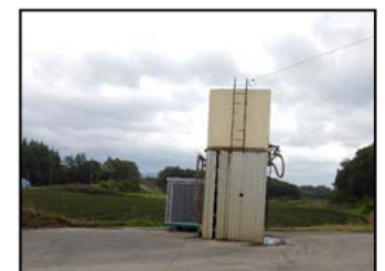
従前の給水施設
