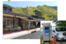
EV車等への給電設備
