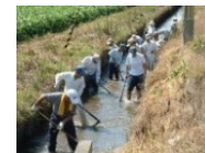
水路の泥上げ
