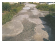
農道の窪みの補修
