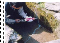
水路のひび割れ補修
