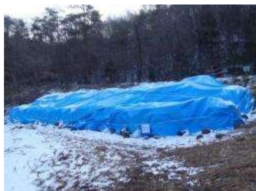
雨水等の浸入防止（ブルーシート掛け）対策の例
