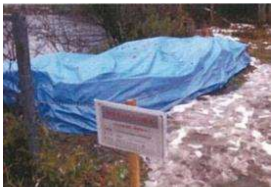
場内の一時仮置き場にて、フレコンバッグをブルーシートで保護
