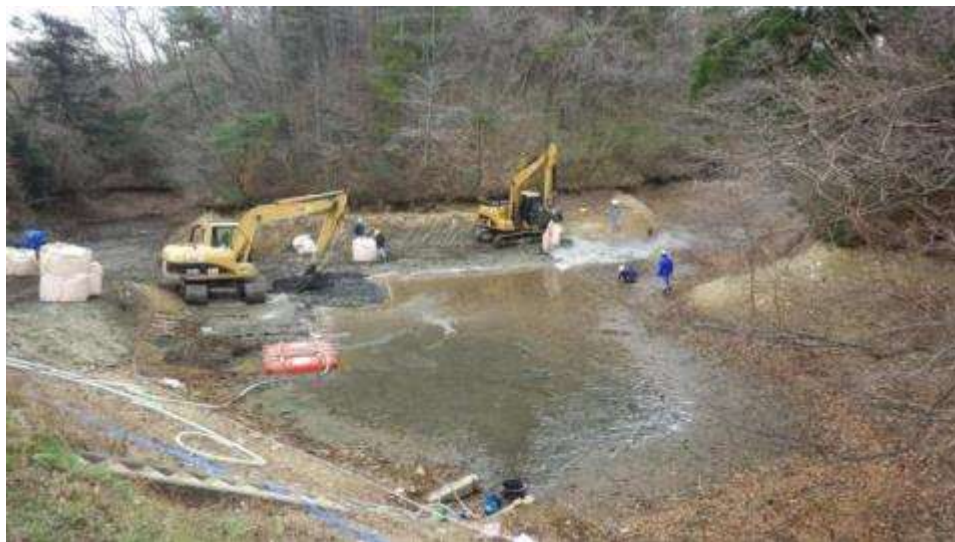
底質固化工法の施工状況
