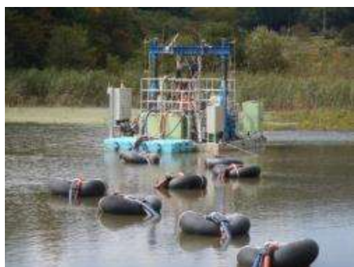
原位置分級浄化装置搭載の作業台船
