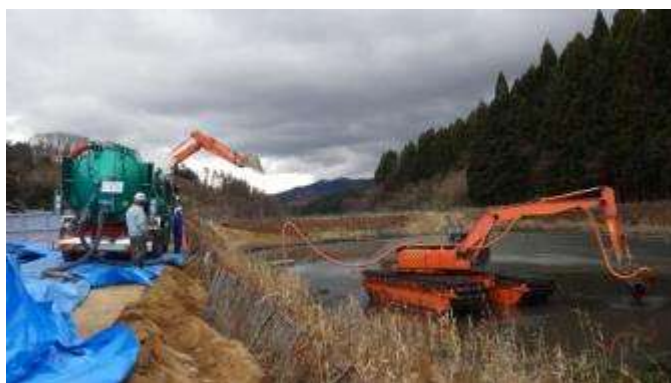
強力吸引車（バキュームカー）による浚渫作業の状況
