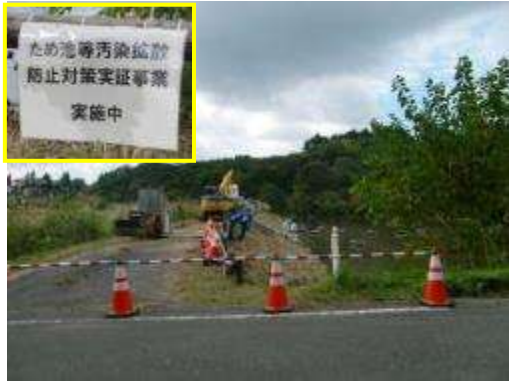
侵入防止柵の設置例
