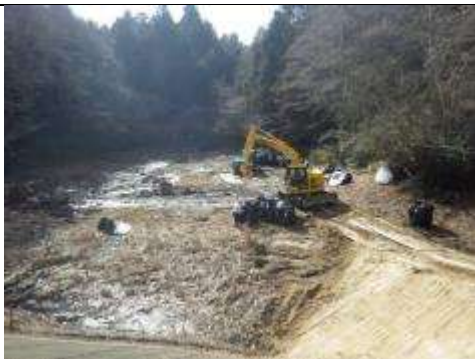
池敷きでの掘削状況
