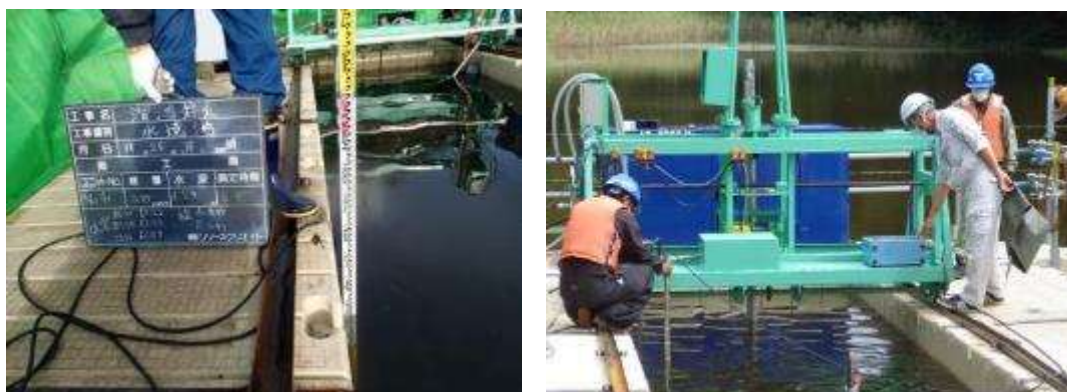
台船上からの浚渫深の測定
