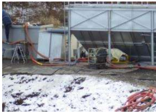
熱機器による解氷作業の状況
