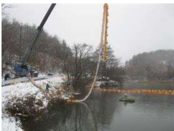
シルトフェンスの池内吊り込み状況
