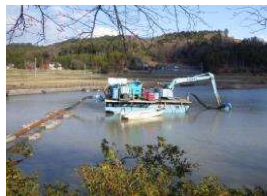
ポンプ浚渫 (吸引圧送機〔自走・台船移動両用〕)
