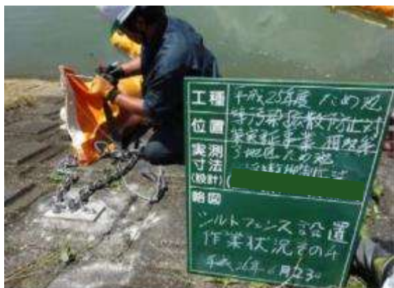
固定プレート設置
