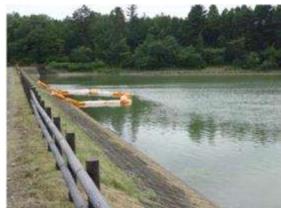
フェンス設置後
