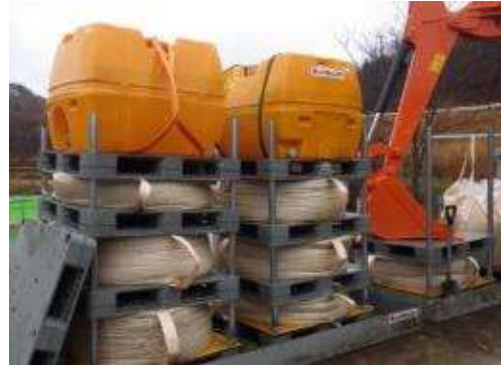
防水パンによる二次脱水
