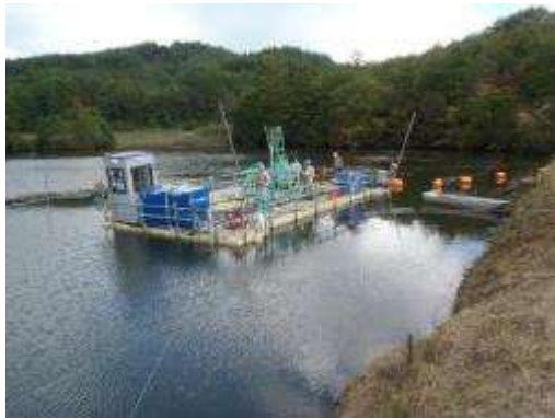
ポンプ浚渫の状況
