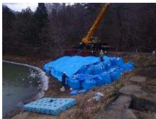
雨水等の浸入防止（ブルーシート掛け）対策の例
