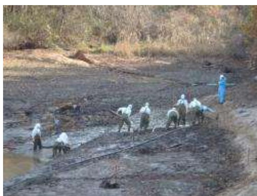
池敷きにおける底質の吸引作業
