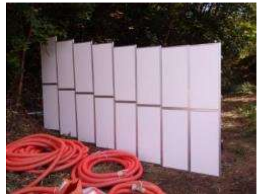
一時的な仮置き場所 遮へい板の設置例
