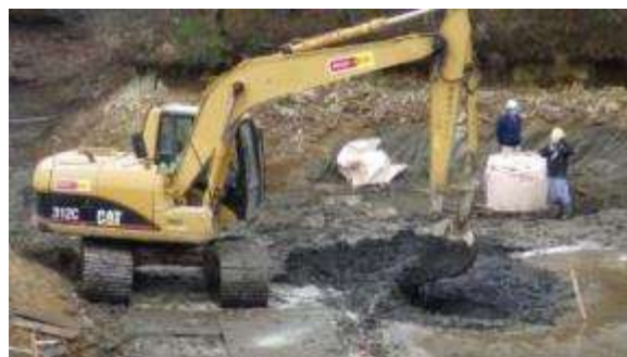
攪拌・混合状況
