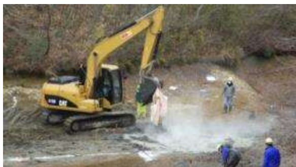
固化材の添加状況
