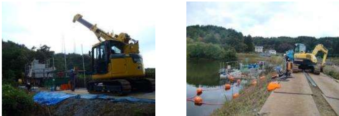
堤体養生工の事例
