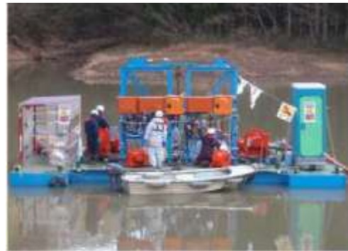
ポンプ浚渫の状況
