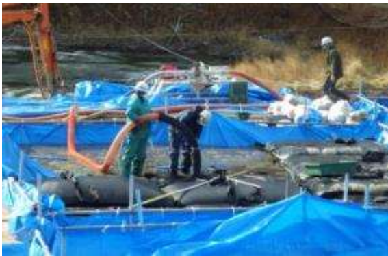
脱水袋への底質の充填作業
