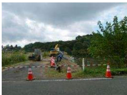
撮影記録例（仮設の設置状況）
