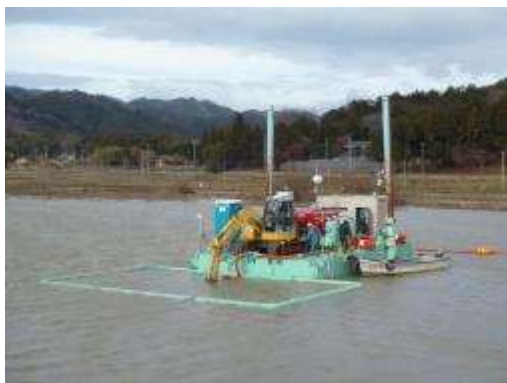
ポンプ浚渫 (アタッチメント式薄層浚渫装置)
