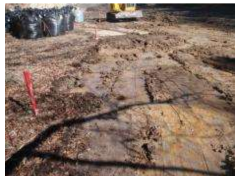
掘削除去後の池敷き状況
