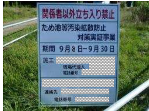
工事看板の設置例
