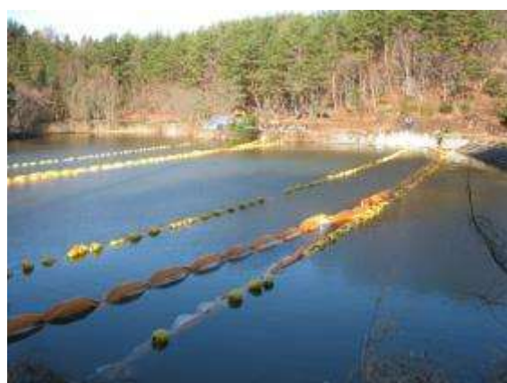
シルトフェンス（多段式）設置後
