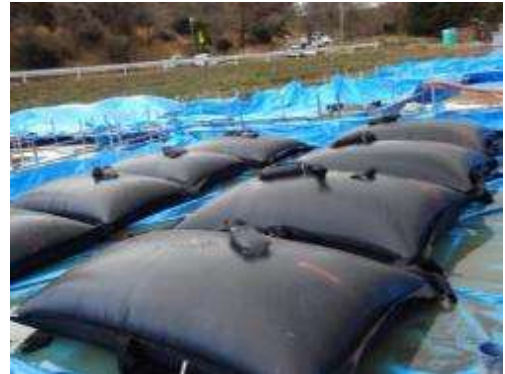
脱水養生中の状況
