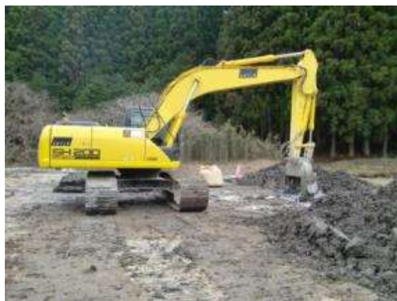
固化材の混合状況
