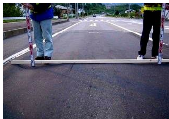
直線定規によるわだち掘れ調査
