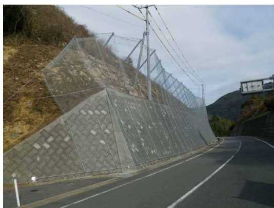
落石防止網設置状況①
