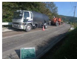
（スタビライザ攪拌） ・乳剤散布 ・セメント攪拌
