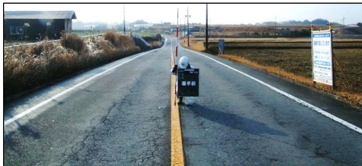
保全対策の対象道路
