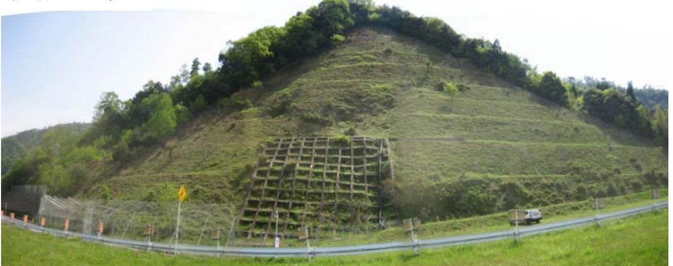
着工前 法面全景
