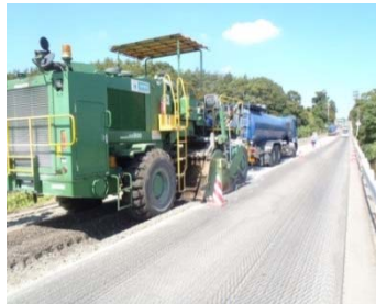
スタビライザー（攪拌混合機械）
