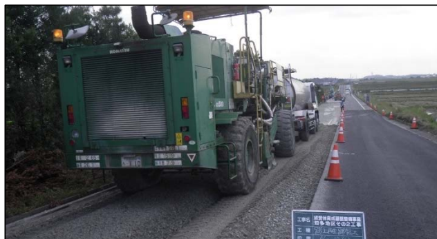
路上再生路盤工法施工状況
