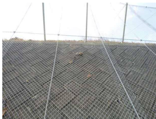
落石防止網設置状況②※落石有
