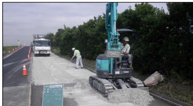
路上再生路盤工法施工状況
