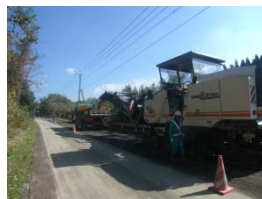
（劣化舗装の掘削） 切削機使用により施 工期間を短縮
