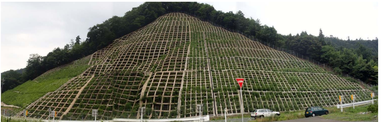
完成後 法面全景
