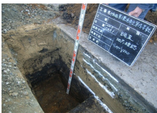
開削による路盤性状確認
