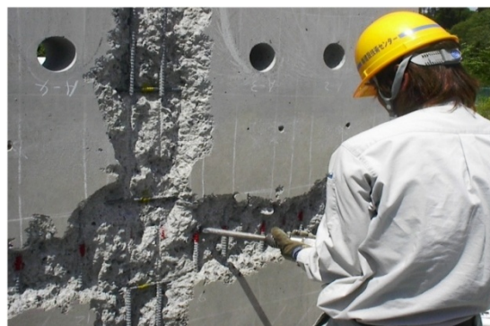
はつり・コア抜きによる確認
