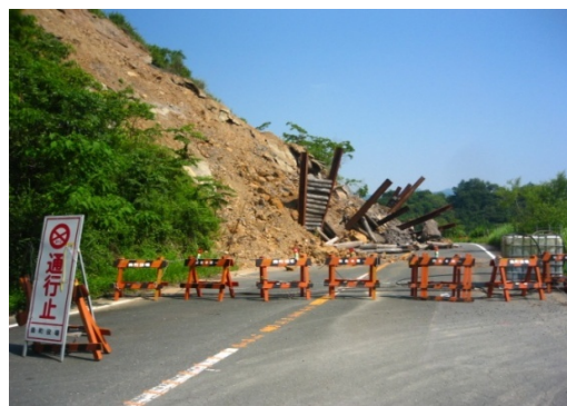
豪雨による土砂崩れの発生
