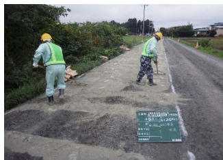
セメント散布状況
