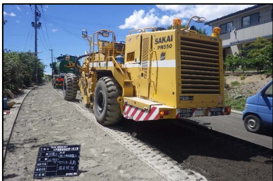
路上再生路盤施工状況
