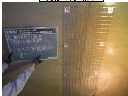
アンカー打込完了
