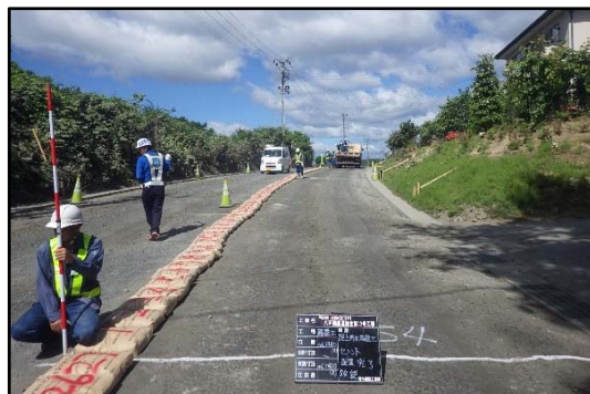
セメント配置状況
