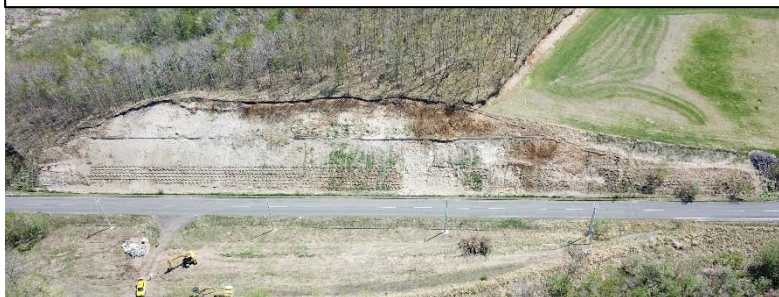
施工後：吹付け後約30日で植生が確認され、法面も安定している
