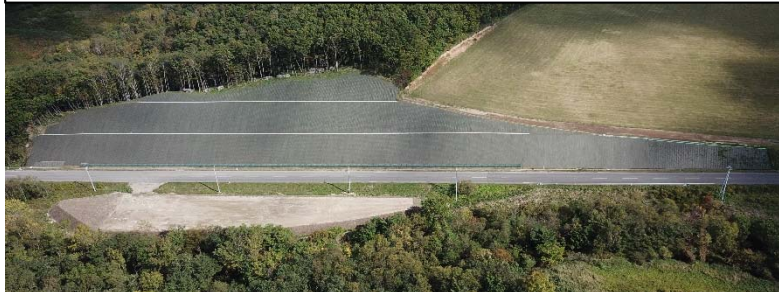
施工後：吹付け後約30日で植生が確認され、法面も安定している
