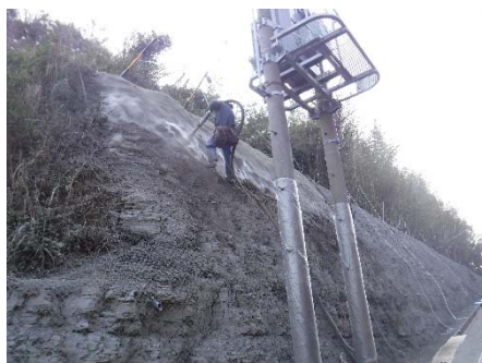
吹付け状況。1段階吹付(写真下部)の上から2段階吹付を行っている。
