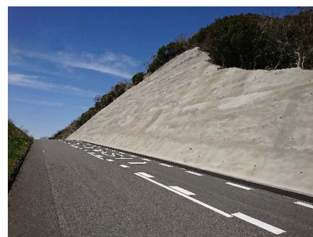
吹付完了。 幹線農道への落石を防ぐ。
