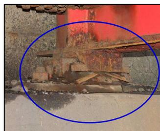
支承部（鋼製）の腐食（錆）
