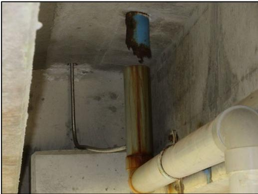
排水管腐食破断
