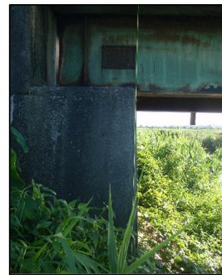
橋台の傾き (下げ振りによる測定)
