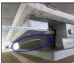
支承部（ゴム製）の壊れ（亀裂）
