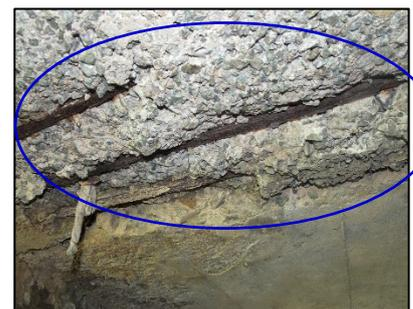
表面の剥がれ落ち、鉄筋露出
