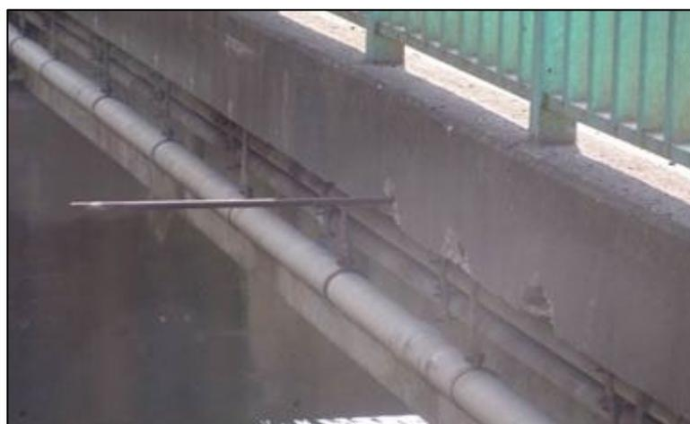
破断して突出した横締めPC鋼材
