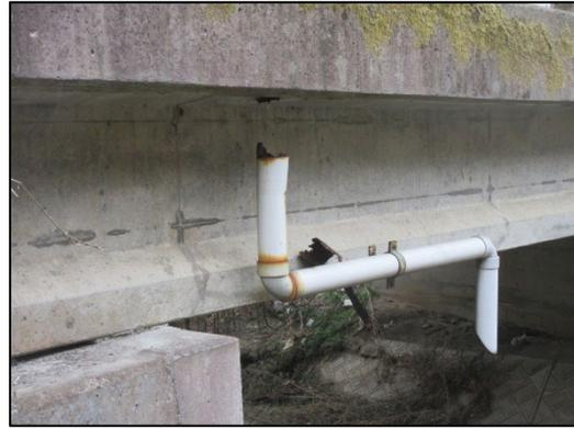
排水管腐食破断
