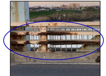
防護柵の劣化（錆・破断）
