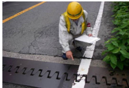
伸縮装置の点検
