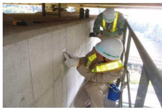
橋脚の近接目視
