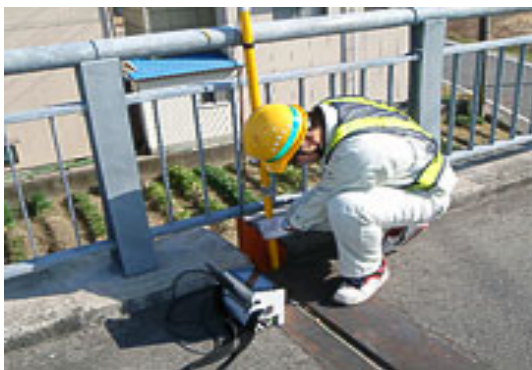
モニターカメラによる上部工点検
