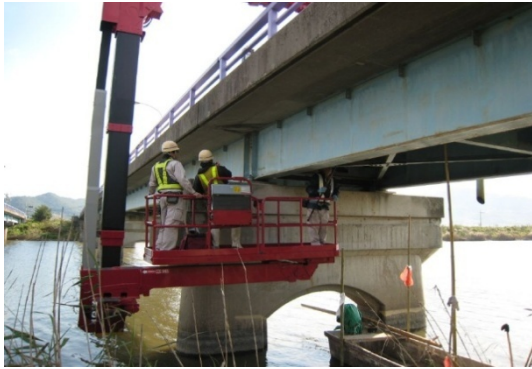
橋梁点検車両による点検
