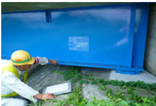
支承部の近接目視
