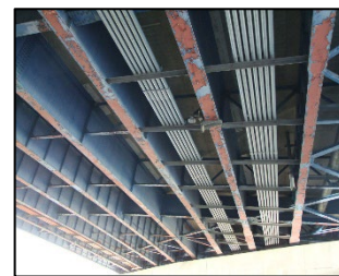
I 桁橋（鋼橋）下面
