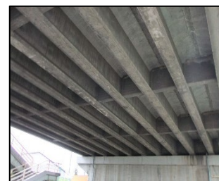
T 桁橋（コンクリート橋）下面
