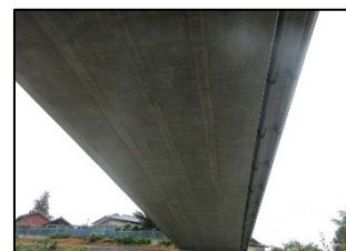
ホーステンション PC 中空床版橋下面
