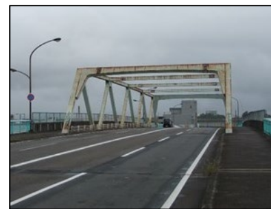
鋼トラス橋（下路式）
