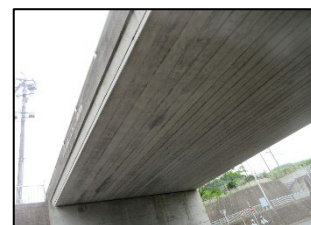
プレテンション PC 中空床版橋下面
