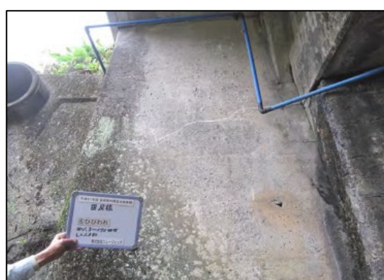
④損傷箇所の位置（橋台クラック）アップと全景
