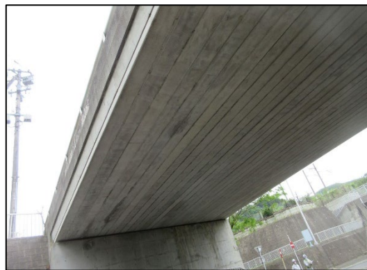
P C 橋下面（プレテンション I 桁橋）
