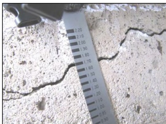
④損傷箇所の位置（橋台クラック）アップと全景
