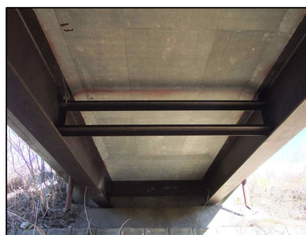
鋼橋（H桁橋）
