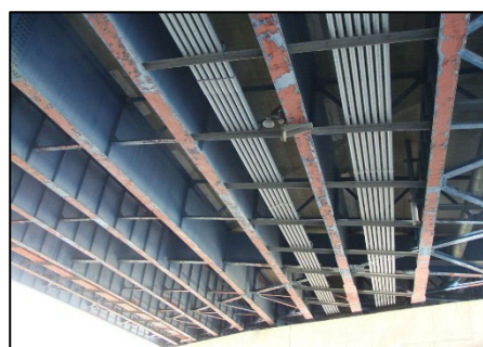
鋼橋（I桁橋）
