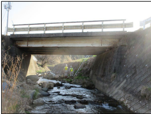
鋼製桁の錆
