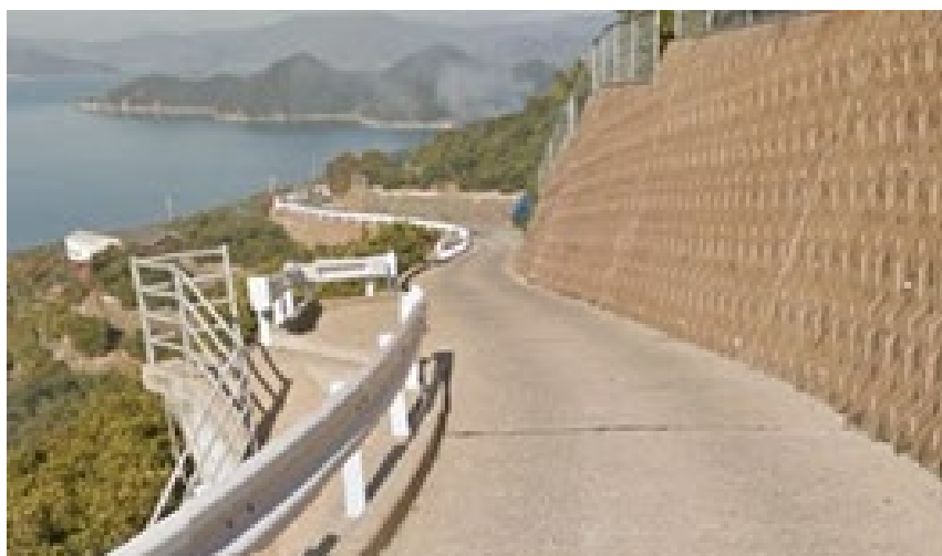
【写真－10 急傾斜地でコンクリート舗装が採用されている事例】
