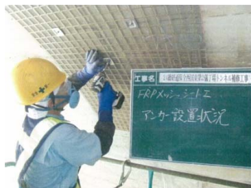
アンカー設置状況
