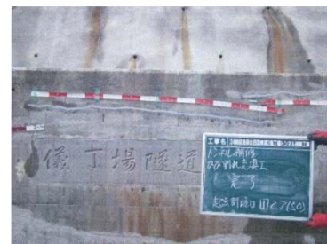
注入・充填工完了
