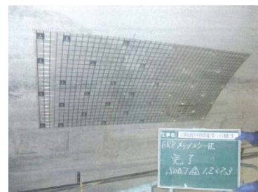
FRPメッシュシート工完了
