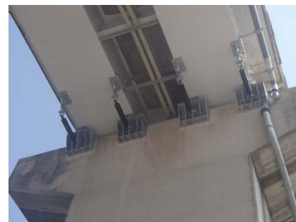
P1橋脚落橋防止
