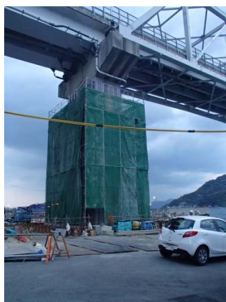
P1橋脚耐震補強工事状況
