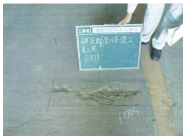
施工前（断面修復）
