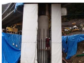
P2鉄筋組立
