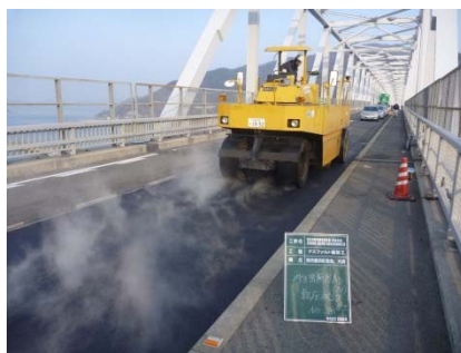
橋面舗装状況
