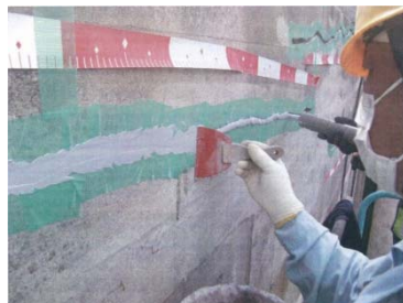
下地処理～充填材施工状況
