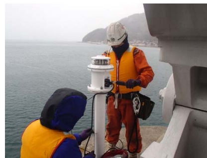
P3橋脚灯設置状況
