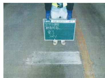
無収縮グラウト工完了
