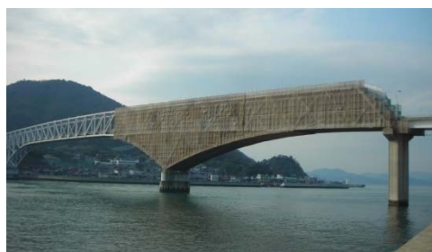
塗装足場設置状況
