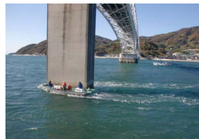
船上からの橋脚点検
