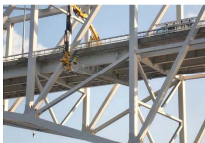
橋梁点検車による点検
