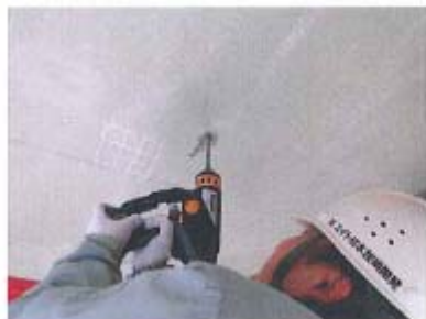
ドリル削孔風景
