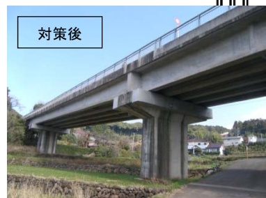
横桁増設工
