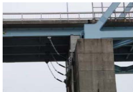
P1橋脚落橋防止
