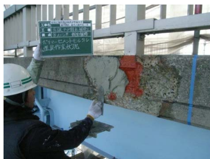
地覆補修(ポリマーモルタル)
