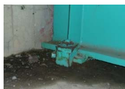
支承保護工補修前
