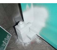
金属溶射・封孔処理
