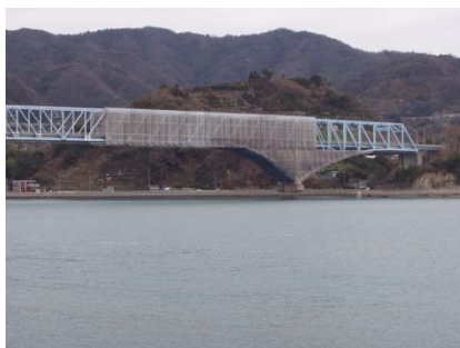
塗装足場設置
