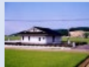
農業集落排水施設
