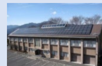
地域資源利活用施設 (太陽光発電施設)
