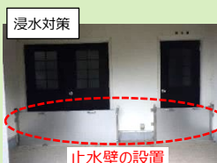
止水壁の設置
