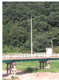
防災無線(公共施設)
