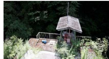
通信不感地帯が多い 上流域の推移監視や遠隔制御
