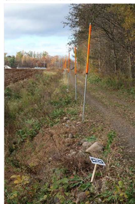
路肩部分のポールの設置 (富良野の実証)
