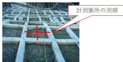
図9-5 梁間隔の算出方法
