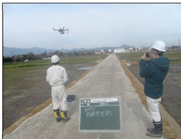
UAVによる3次元測量
