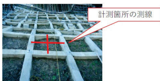
図 9 - 5 梁間隔の算出方法
