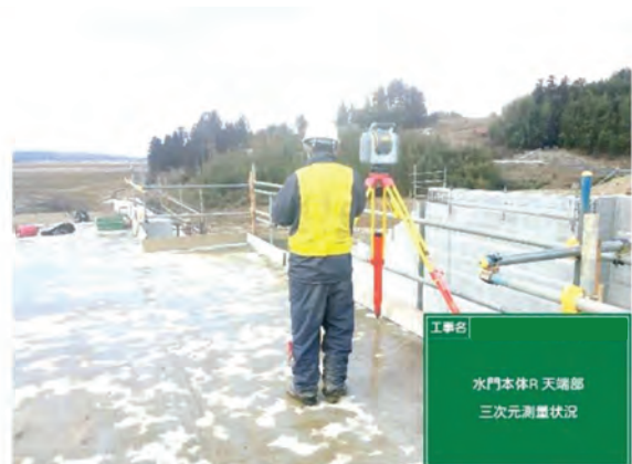
3D計測状況（壁上面）
