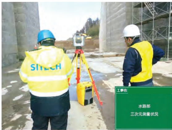
3D計測状況（壁側面）
