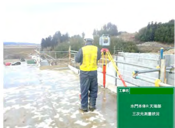
3D 計測状況（壁上面）
