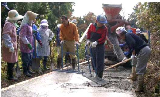
道路を住民がコンクリート舗装
