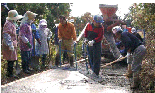
道路を住民がコンクリート舗装
