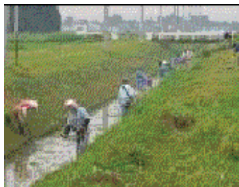
水路の泥上げ
