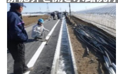
排泥弁を開き水路洗浄
