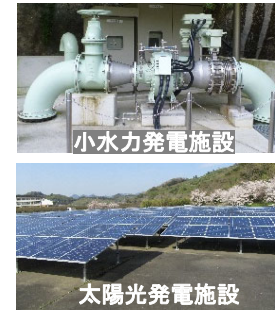
太陽光発電施設
