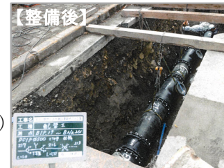
パイプラインの敷設替(更新)
