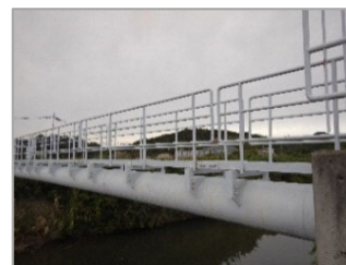
老朽化した水管橋
