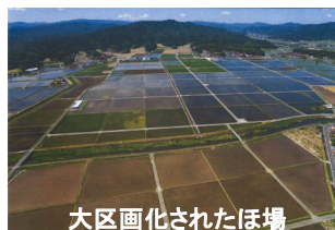
大区画化されたほ場
