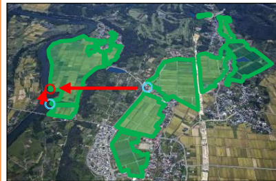
揚水機場の集約
