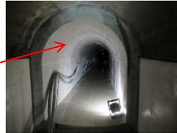
靱性モルタル吹付による側壁部の補修
