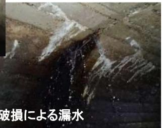
継目破損による漏水
