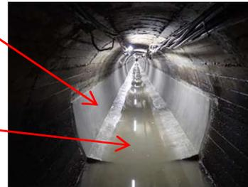
コンクリート打設による底版の補修
