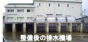
整備後の排水ポンプ
