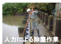
スクリーンのみの除塵設備
