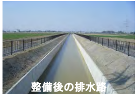
整備後の排水路
